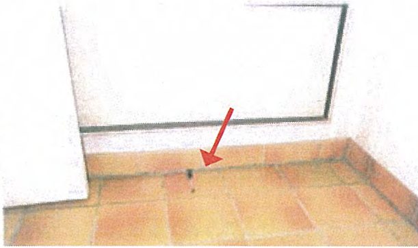
Affaissement du plancher mis en évidence par le décollement entre plinthes et dallage - Maison Jourdan.
